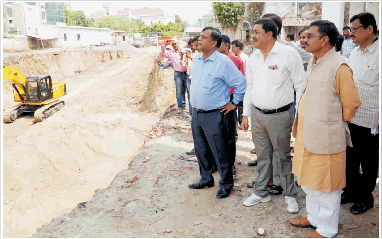
राज्य मंत्री (सूचना) डॉ. नीलकंठ तिवारी, सूचना एवं जनसंपर्क विभाग के निर्माणाधीन भवन का स्थलीय निरीक्षण करते हुए
